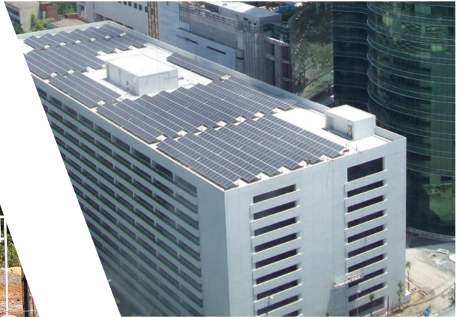
330 kW Solar Rooftop : อาคารจอดรถ Energy Complex
