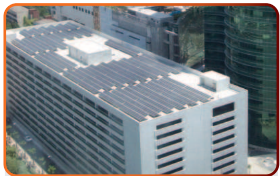
Solar Rooftop : อาคารจอดรถ Energy Complex
